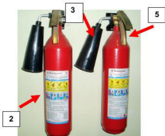
Рисунок 5 - Углекислотный огнетушитель типа ОУ-3
